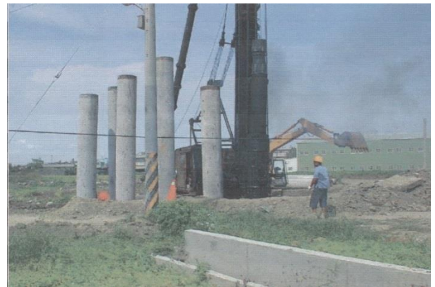
南勢重劃橋樑工程施工
